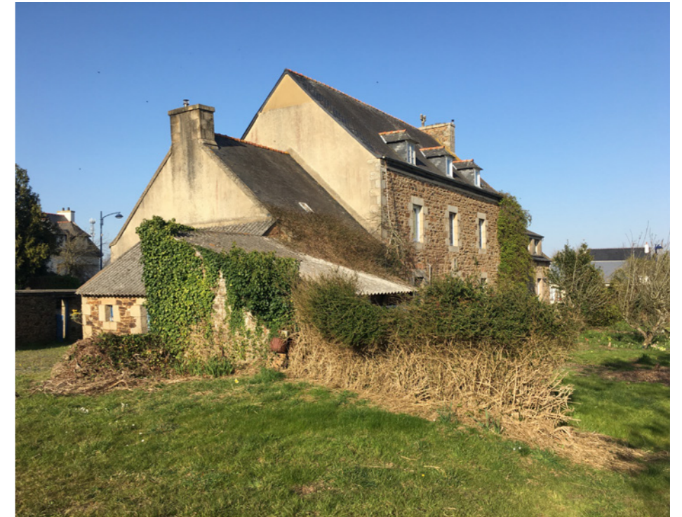
↑ Deux appentis à démolir
